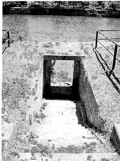
選奨土木遺産に選ばれた「京橋川雁木群」の雁木の一つ。上り口の天井に石が渡してある (広島市中区橋本町)
